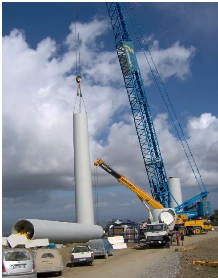
Gamesa Eolica Italia srl - WF Montecute- Lavori di sollevamento e montaggio di 21 Aerogeneratori Eolici del tipo Gamesa G-87
