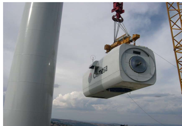
Gamesa Eolica Italia srl - WF Montecute- Lavori di sollevamento e montaggio di 21 Aerogeneratori Eolici del tipo Gamesa G-87
