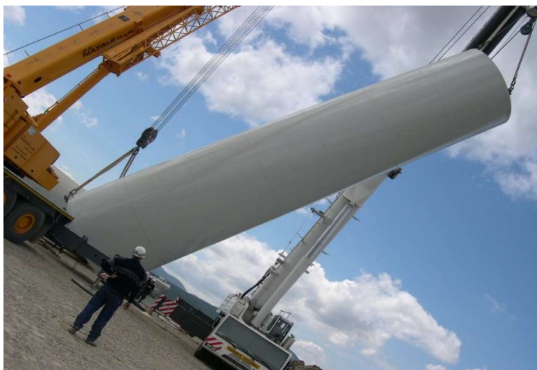
Gamesa Eolica Italia srl - WF Montecute- Lavori di sollevamento e montaggio di 21 Aerogeneratori Eolici del tipo Gamesa G-87
